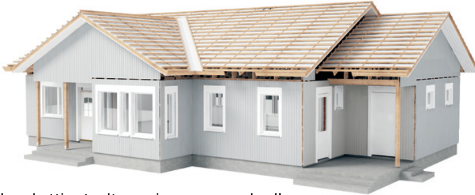
Talopaketti sateelta suojaan -asennuksella
