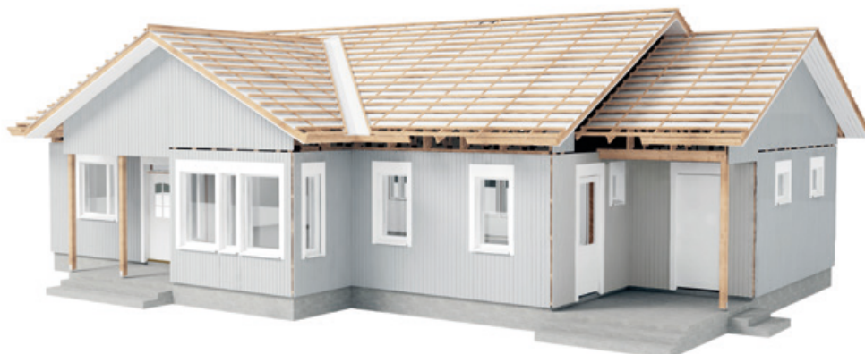
Talopaketti sateelta suojaan -asennuksella
