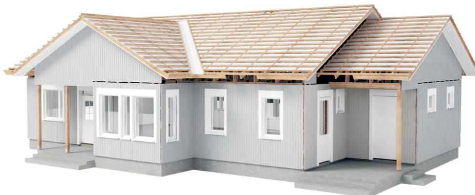
Talopaketti sateelta suojaan -asennuksella
