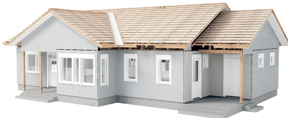
Talopaketti sateelta suojaan -asennuksella
