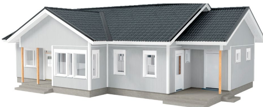
Talopaketti puuverhous valmis -asennuksella
